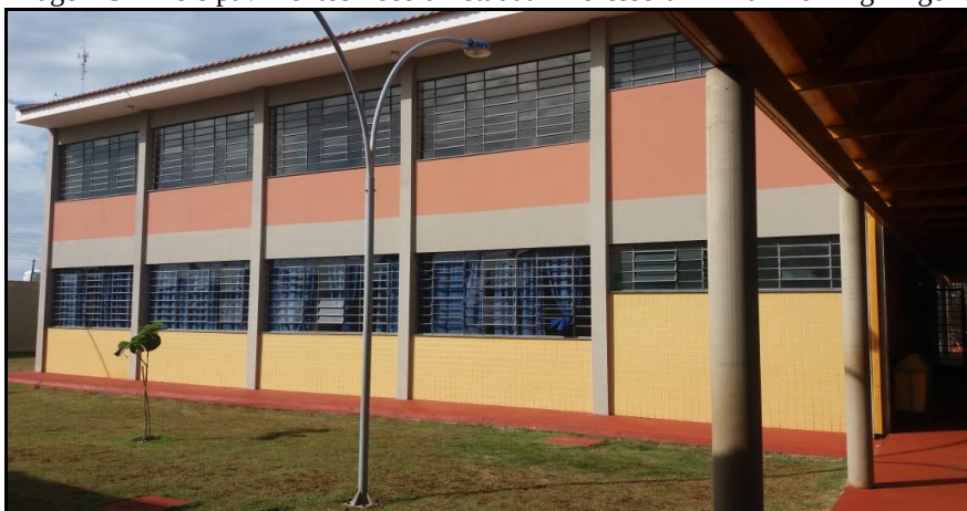
Imagem 5 – Dois pavimentos Escola Estadual Professora Dilma Krohling Angélico
