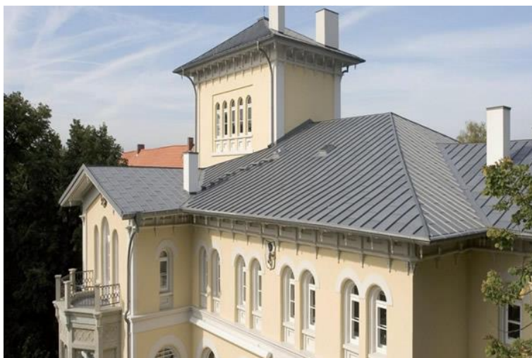
Figura 2: Cobertura em zinco
