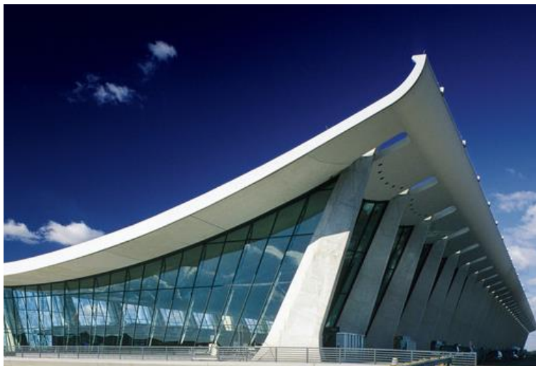
Figura 10: Uso do concreto: Aeroporto Internacional de Dulles Washington
