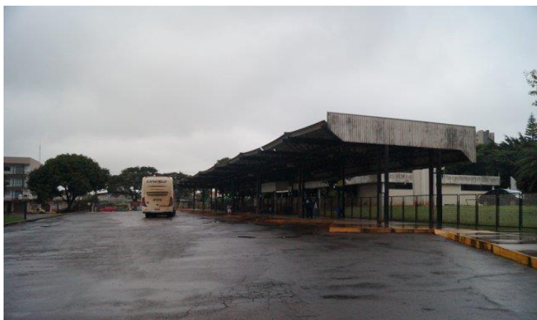
Figura 27: Vista do terreno – Rua Goiás
