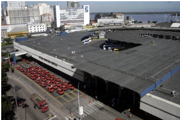
Figura 24: Cobertura: Estação Rodoviária de Porto Alegre
