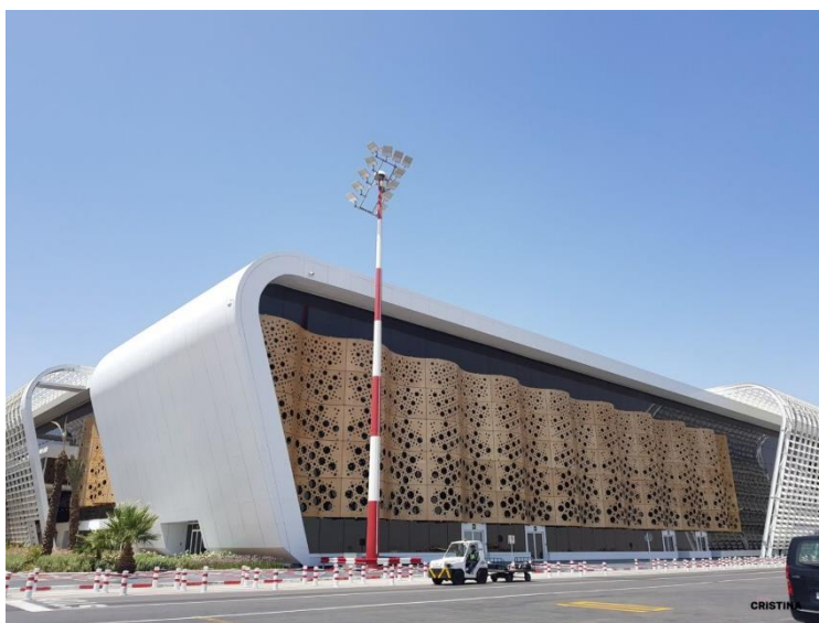
Figura 18: Painéis vazados: Aeroporto de Marrakech
