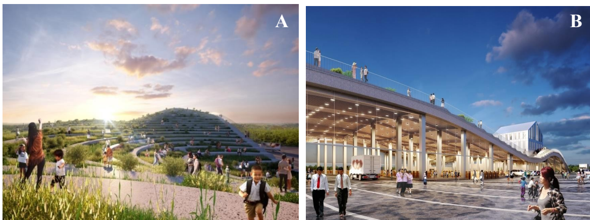
Figura 1 – A, Mercado de Tainan: telhado e paisagem; em B, telhado e passarela.
