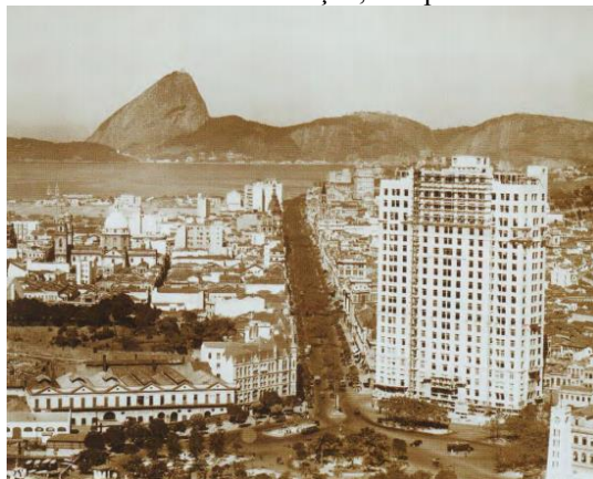
Figura 2: Edifício “A Noite” em construção, Joseph Gire e Elisário da Cunha Bahiana (1929).
