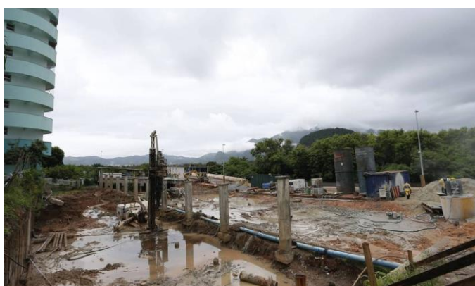
Figura 22: Trecho Final da Primeira parte das Obras no Vila Pan
