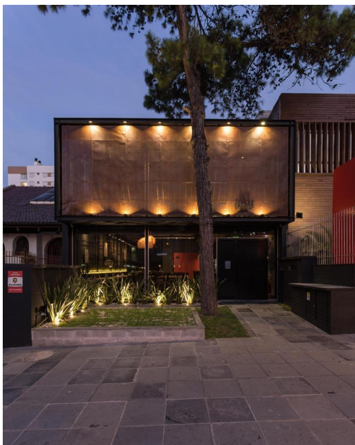
Figura 22: Fachada do restaurante.
