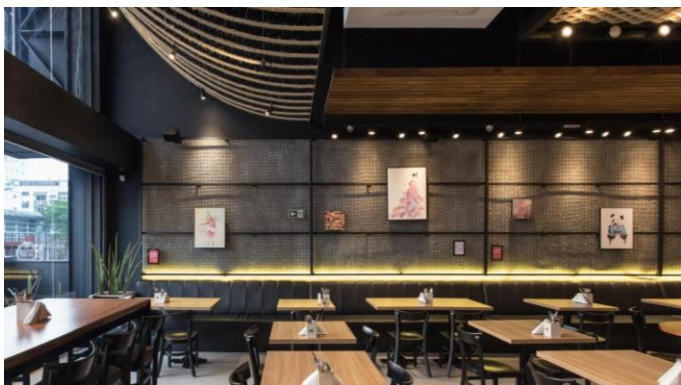
Figura 30: Parede chapiscada destinada ao painel aramado para pendurar quadros.
