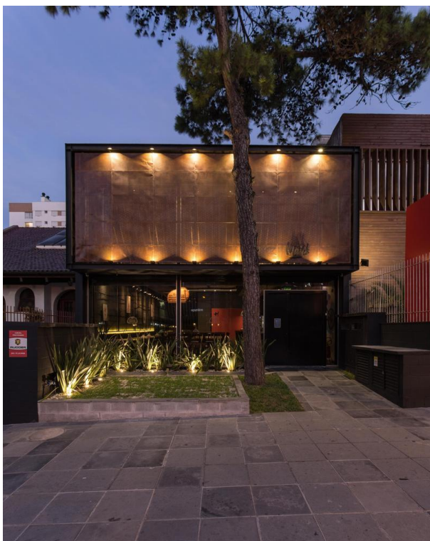
Figura 19: Fachada do restaurante
