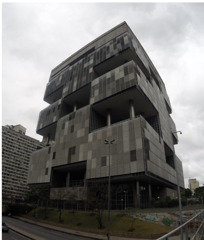
Imagem 01: Vista do viaduto da Av. Republica do Paraguai.
