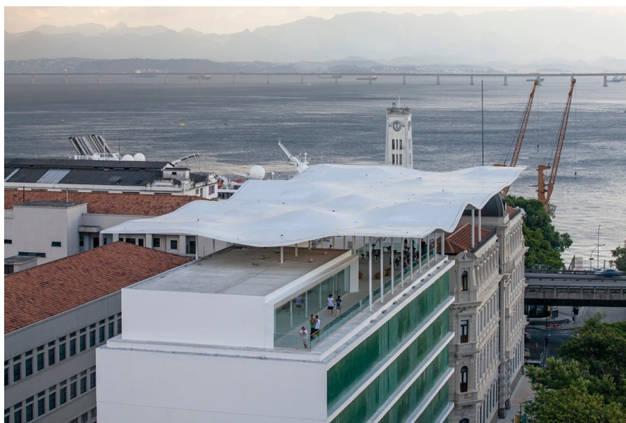
Imagem 11: Cobertura e praça suspensa.
