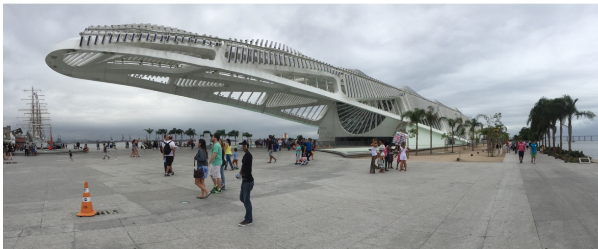
Imagem 12: Fachada sul (entrada) do museu, mostrando o balanço de 75 metros.
