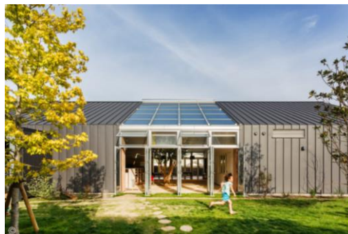
Figura 8: Creche HN – Fachada
