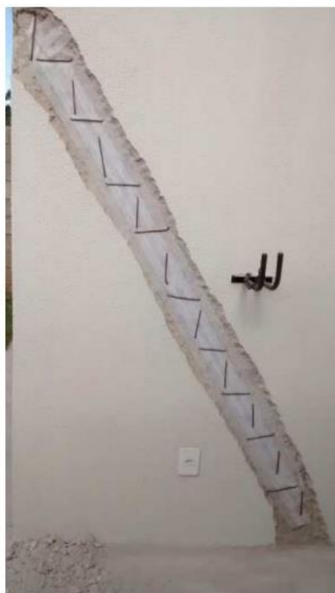
Figura 18: Estrutura recuperada com o uso de grampos.
