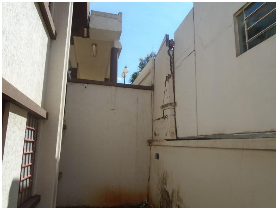
Figura 12: Muro de contenção.
