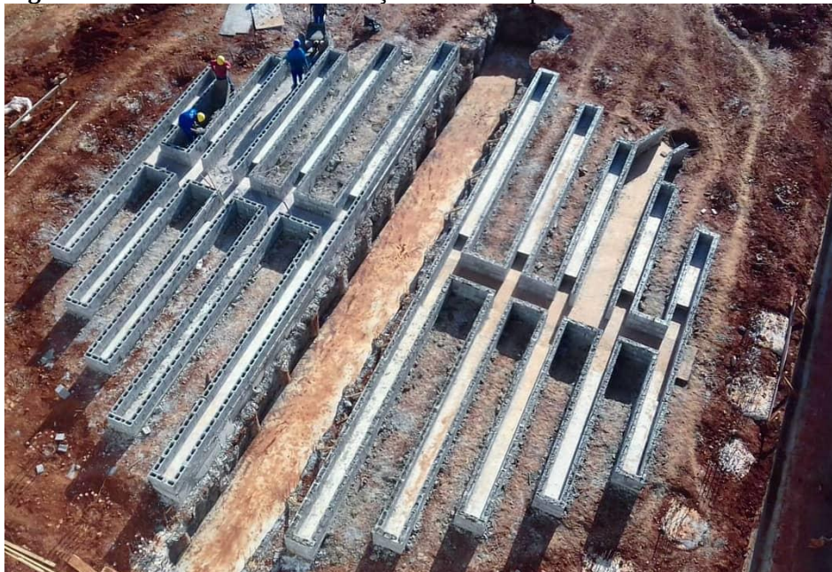
Figura 3: Dutos e canaletas de aeração utilizando parede em bloco de concreto
