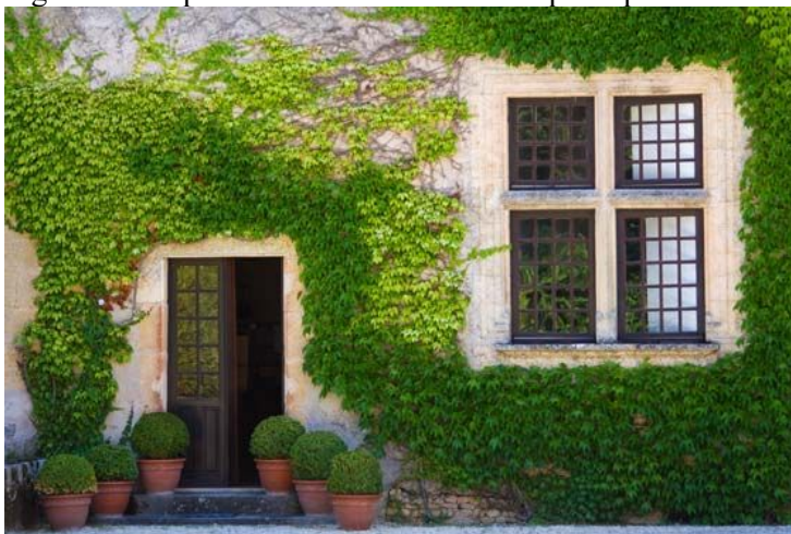
Figura 1 - Trepadeiras cobrindo a fachada principal
