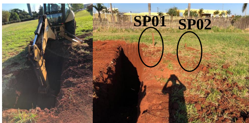
Figura 11: Retroescavadeira realizando a abertura da vala, seguido da vala, já aberta
