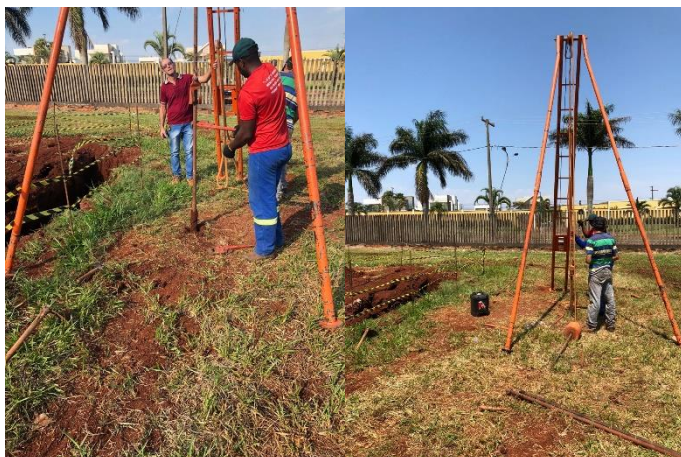
Figura 12: Execução dos furos SP03 e SP04 ao lado da escavação
