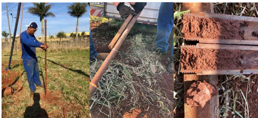
Figura 10: Escavação do primeiro metro com um trado-helicoidal, marcação da haste com giz e amostra de solo coletada do amostrador
