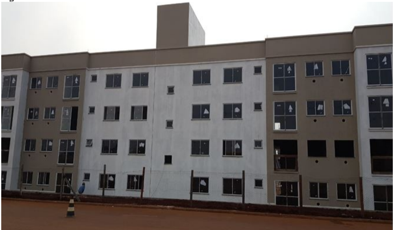
Figura 3 - Fachada do bloco.
