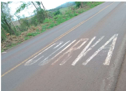
Figura 8: Pintura comprometida e Faixas com baixa visibilidade
