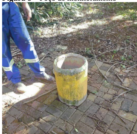
Figura 8 – Poço de monitoramento
