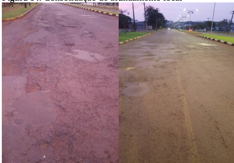
Figura 14: Consolidação de afundamento local
