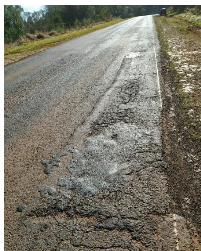
Figura 16: Remendo KM 39 lado direito
