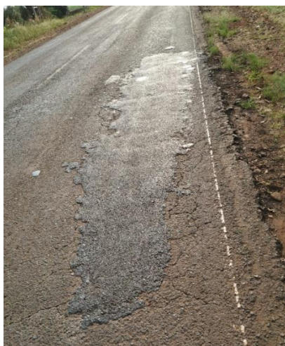
Figura 15: Remendo KM 41 lado direito
