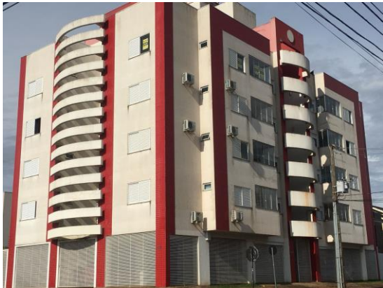
Figura 8: Vista frontal da edificação.
