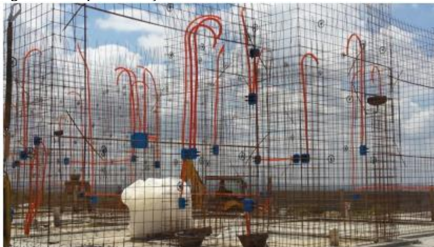
Figura 01: Etapa da armação das telas soldadas.
