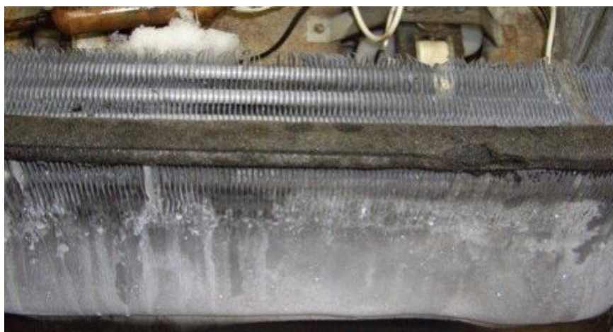
Figura 1: Formação de gelo no evaporador
