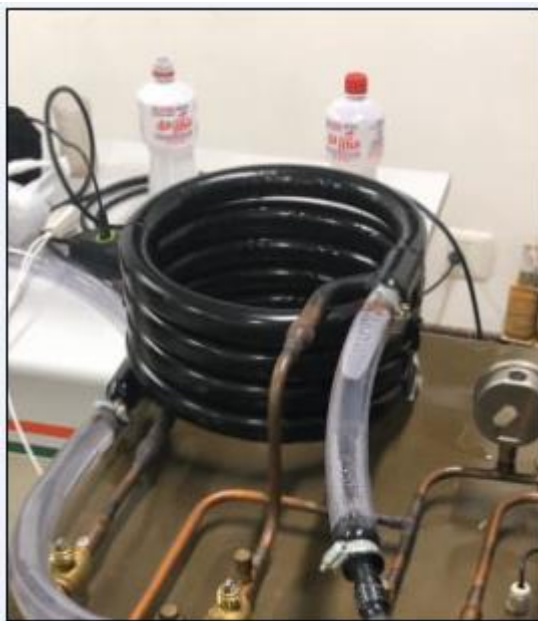
Figura 18: Trocador de calor duplo tubo disposto na bancada.
