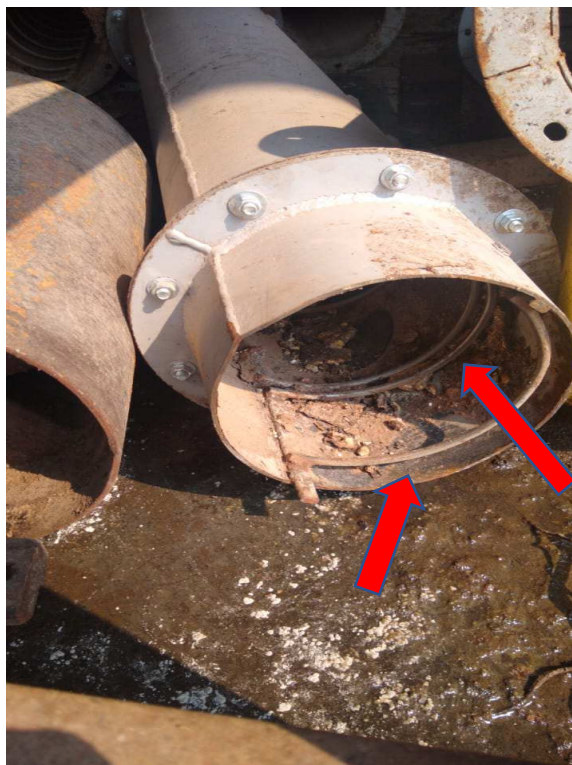
Figura 11: Canalização com revestimento por grade interna.
