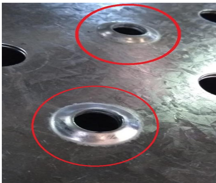
Figura 3: Processo de repuxo nas chapas de pisos de passarela
