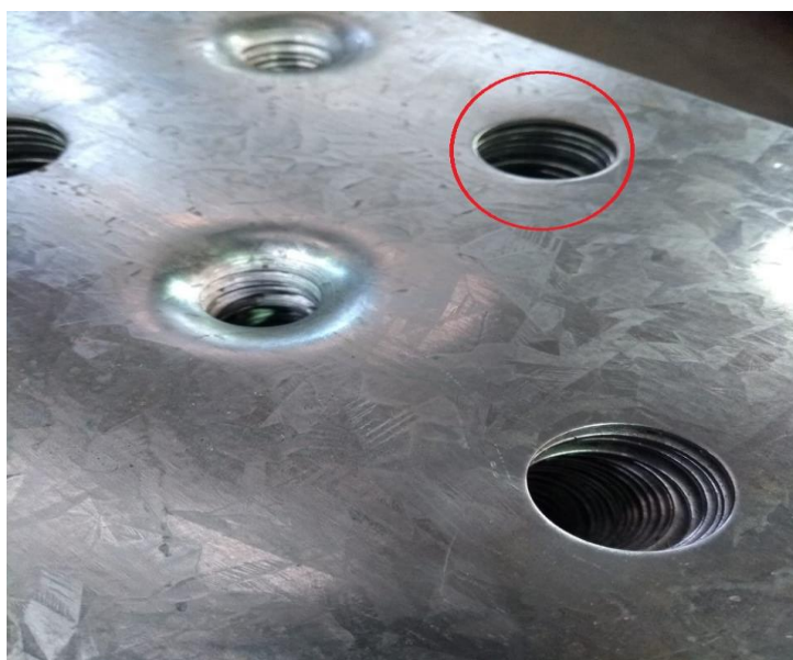
Figura 2: Furação realizada por cisalhamento na chapa de piso das passarelas
