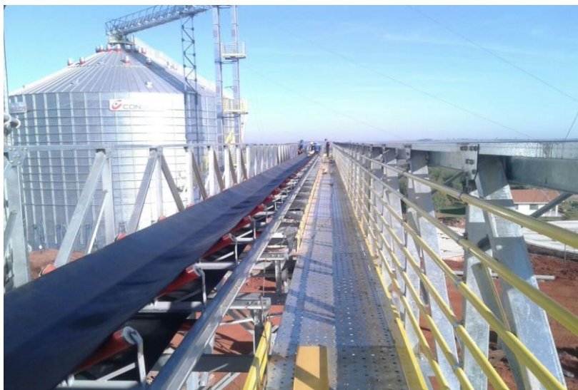
Figura 5: Passarela e correia transportadora em fase de montagem
