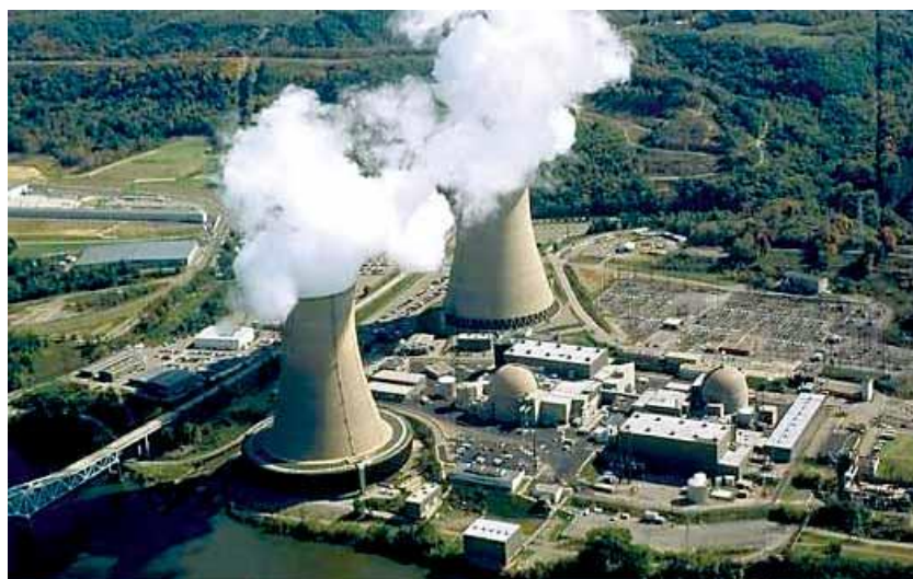
Figura 5: Torre de resfriamento de água atmosférica com configuração hiperbólica
