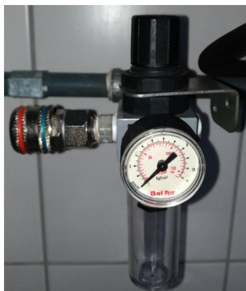
Figura 14: Válvula reguladora de pressão
