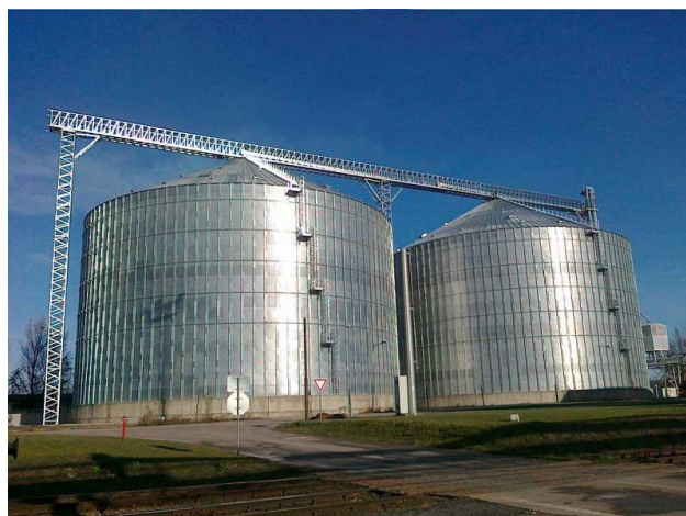
Figura 3 - Bateria de silos metálicos
