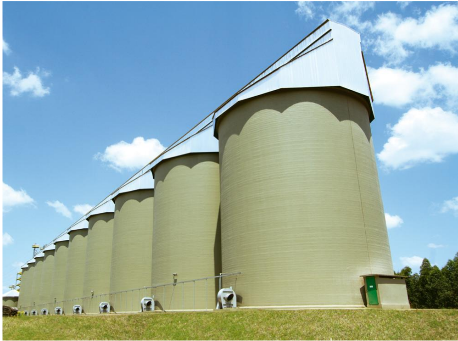
Figura 4 - Bateria de silos de concreto
