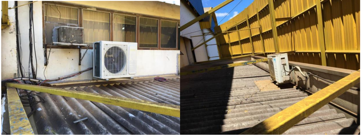
Figura 8: Unidades condensadoras.
