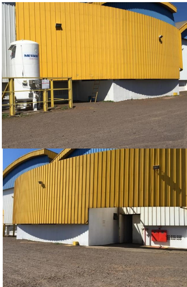
Figura 5: Sala de engenharia
