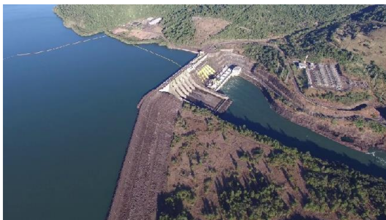
Figura 1: Usina Hidrelétrica Salto Osório
