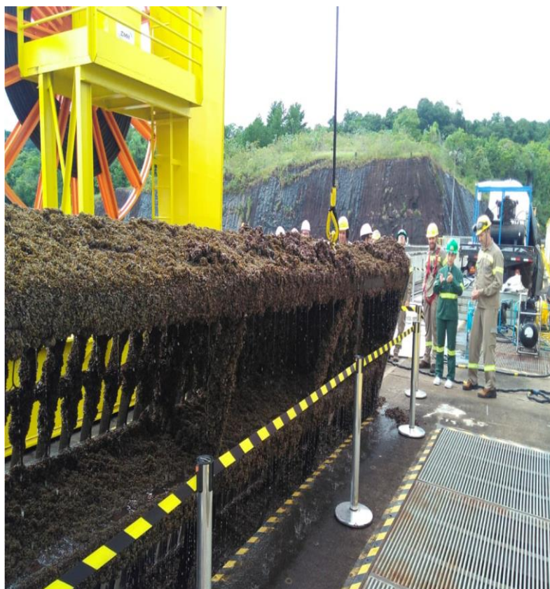
Figura 3: Grade da tomada d'água
