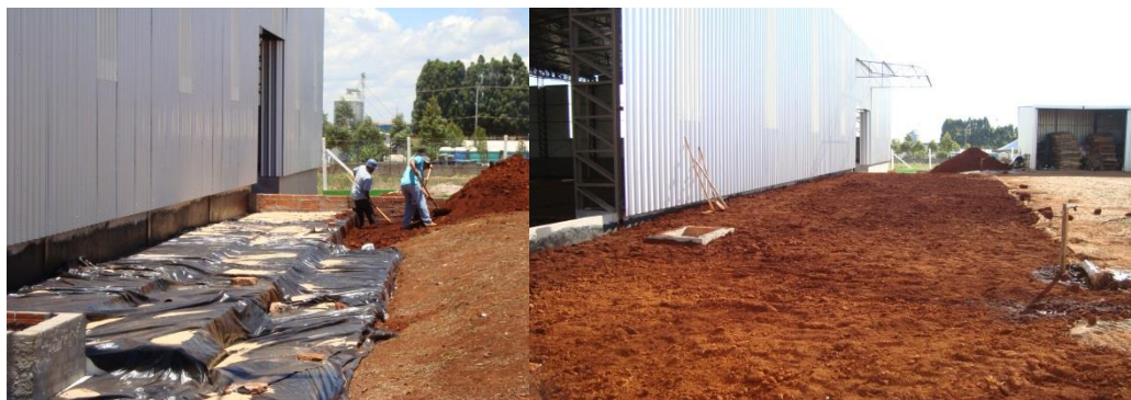
Figura 11 - Nivelamento no solo com EPS
