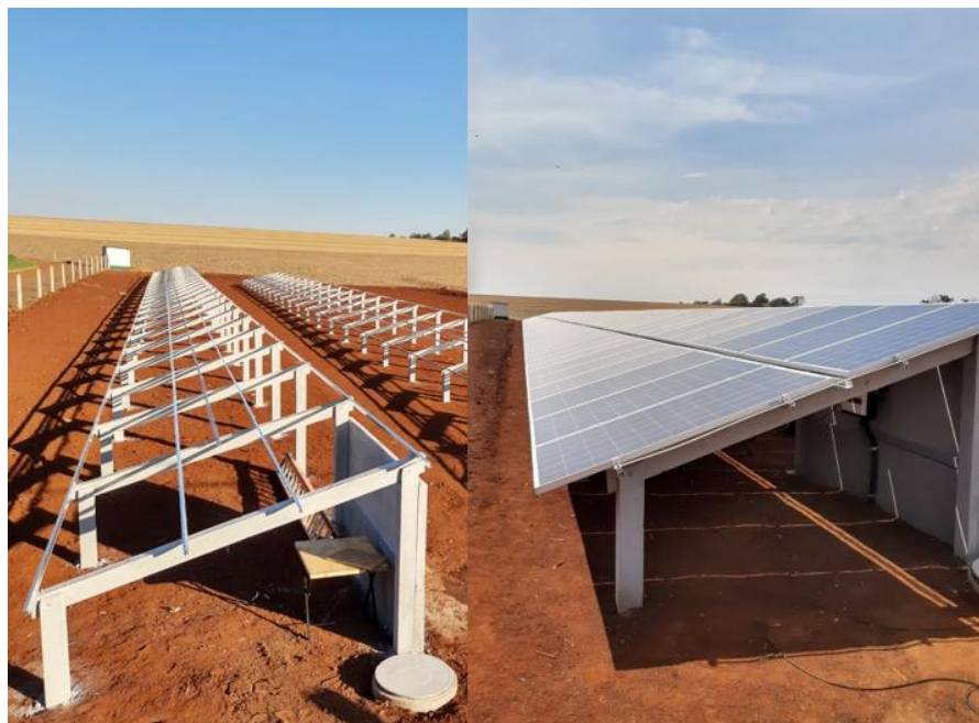
Figura 23 - Estrutura solo em concreto
