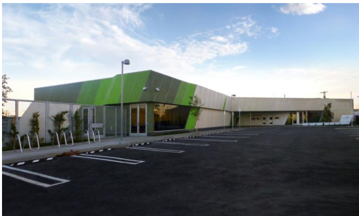
Figura 12: Estacionamento South Angels Care Center
