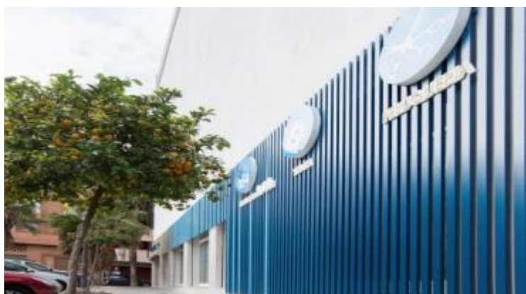
Figura 28: Tiras metálicas do Hospital Veterinário Constitución
