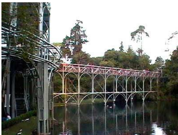
Figura 12: Passarela de acesso à Ópera de Arame
