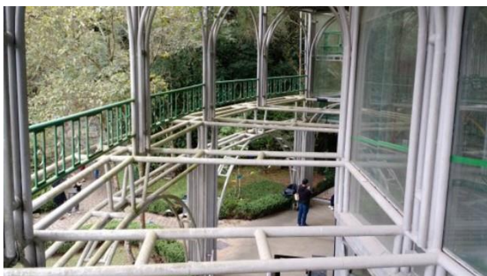
Figura 16: Método construtivo de tubos de aço
