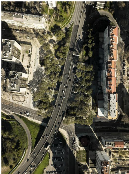
Figura 14 – Vista superior mostrando a arborização da praça e o viaduto
