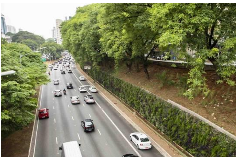
Figura 3 – Avenida 23 de Maio com a parede verde aplicada.
