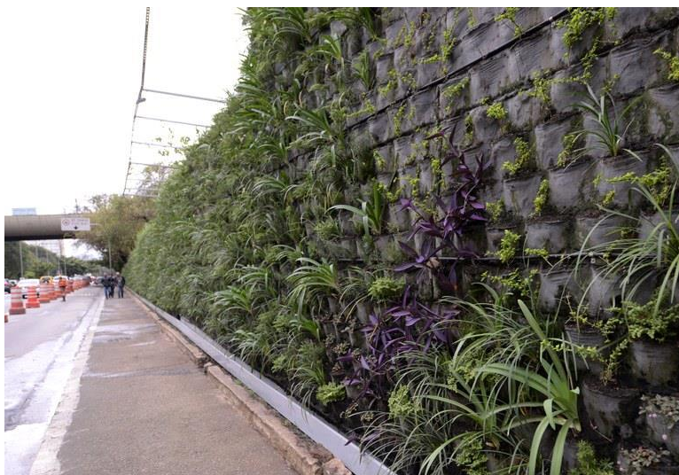
Figura 4 – Técnica aplicada nos muros da 23 de maio.
