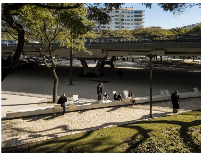
Figura 20 – Área da praça em conexão com o viaduto.
