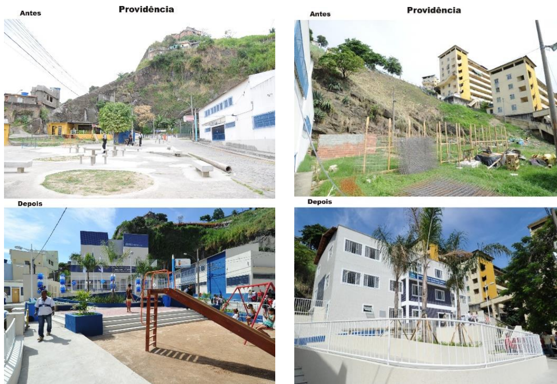
Figura 49: Intervenções no Morro da Providência
