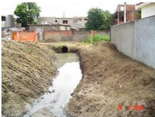
Figura 40: Intervenção em valão do Jardim Morićaba
