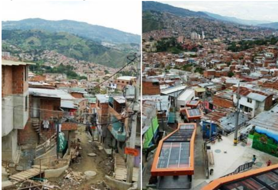
Figura 18 - Antes e depois: escadas rolantes construídas
