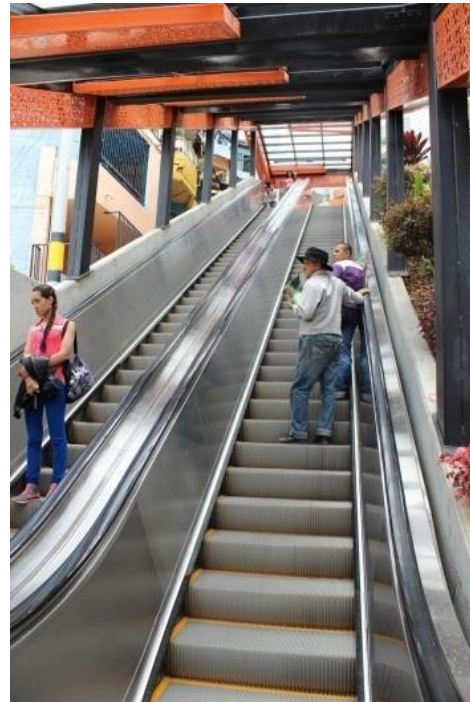
Figura 20 - Escadas rolantes na Comuna 13
