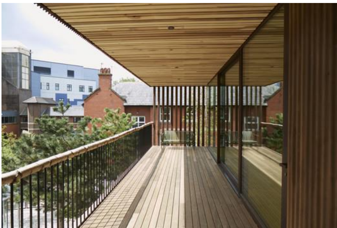
Figura 20: Painéis de madeira no exterior do centro maggie.
