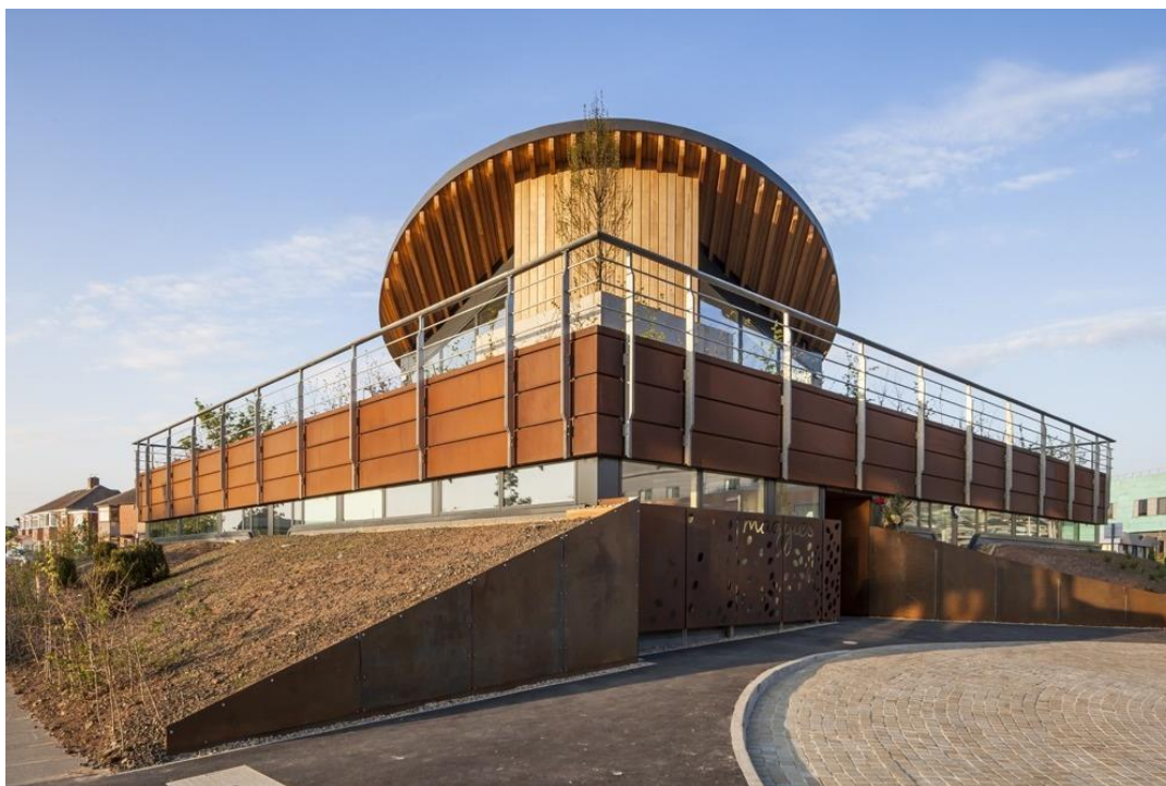
Figura 31: Desnível do Centro Maggie de Newcastle.
