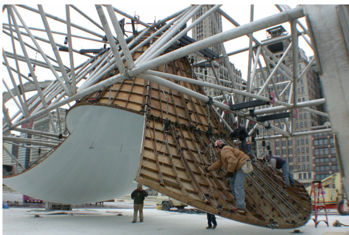
Figura 8: Construção do Cloud Gate
