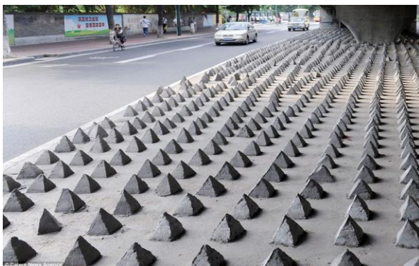
Figura 05 – Spikes de concreto sob uma ponte na cidade de Guangzhou na China.
