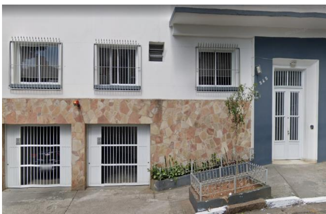
Figura 29 – Grades instaladas nos canteiros de uma residência na capital paulista.
