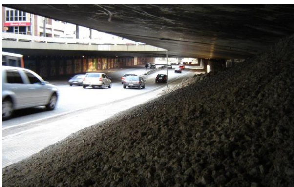
Figura 28 – Rampa antimendigo instalada sob túneis em São Paulo.
