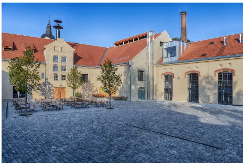
Figura 12: The Kamenice Brewery: fachada e pátio. Fonte: Archdaily (2020).
