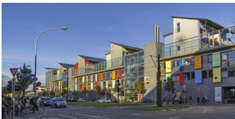
Figura 6: Infraestrutura do Bairro Vauban
