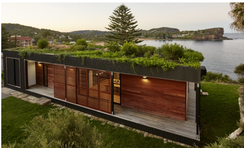
FIGURA 32: Fachada Casa Avalon
