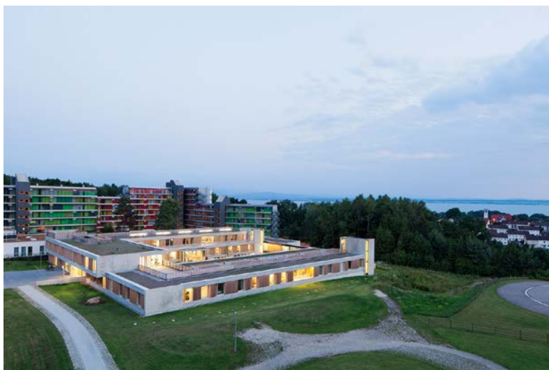
Figura 12: Centro Psiquiátrico Friedrichshafen
