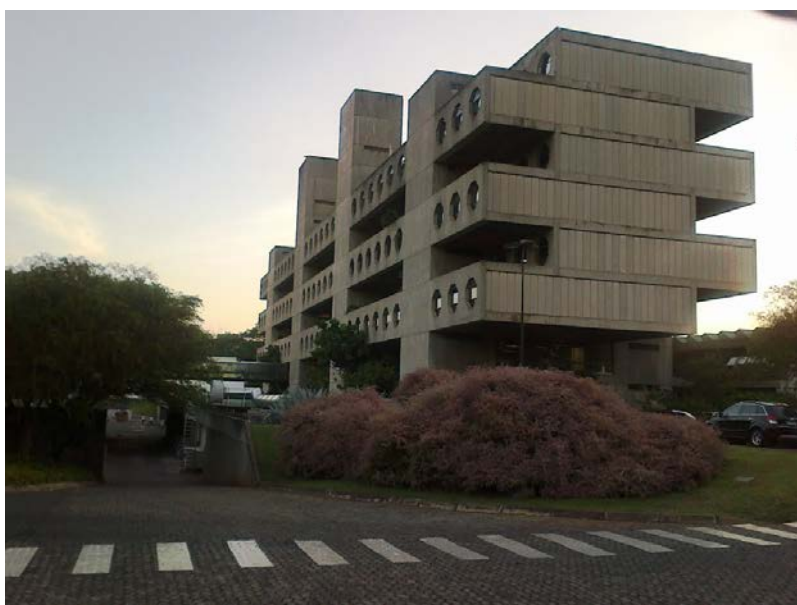
Figura 07: Hospital do Aparelho Locomotor
