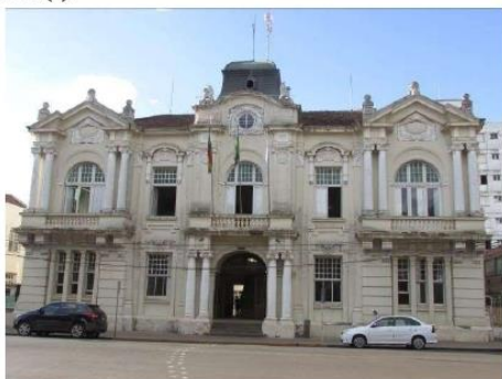
Fachada Prédio da Prefeitura Municipal
