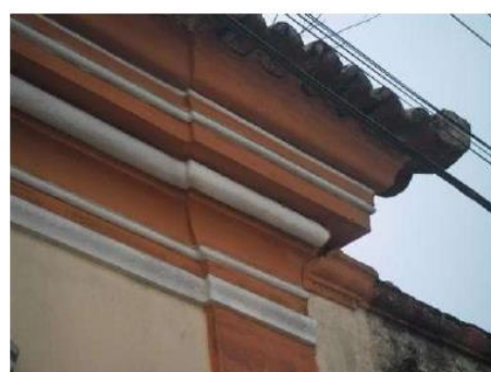
Figura 19: Detalhe cimalha. Fonte: A autora, 2012.
