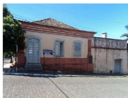
Figura 16: Fachada lateral. Fonte: A autora, 2012.
