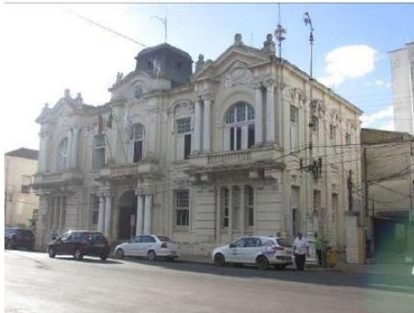
Fachada diagonal direita
