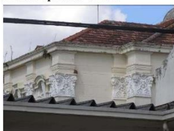
Parte do telhado
