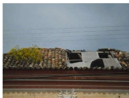
Figura 17: Detalhe telhado danificado e com vegetação daninha. Fonte: A autora, 2012.
