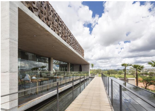
Figura 21- Passarela de aço galvanizado e madeira
