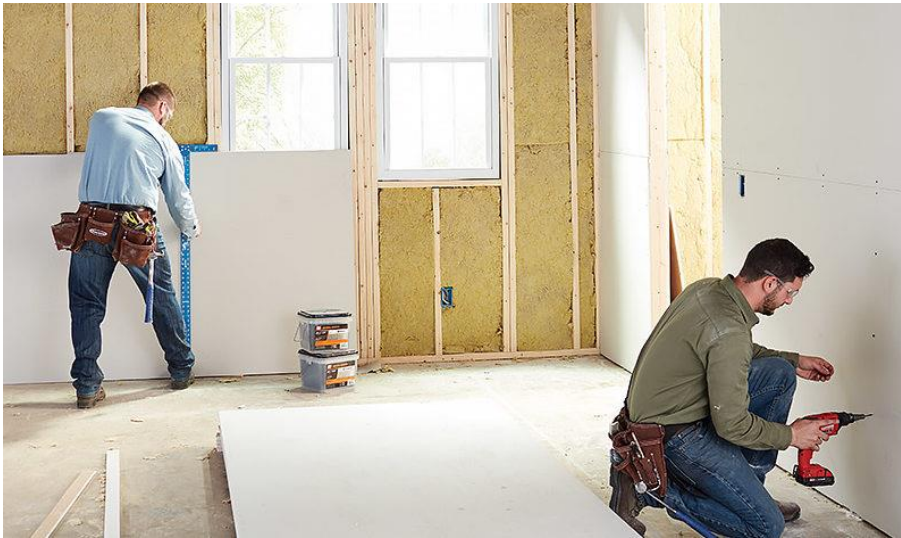
Figura 2 - Demonstração de uma parede Drywall
