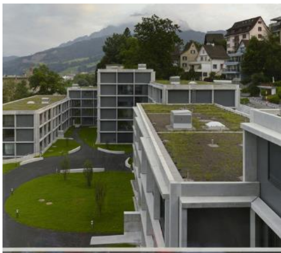
Figura 8: Moradia Estudantil em Luzern: Telhados verdes
