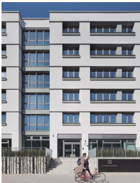
Figura 26: Presença de vidros na Moradia Estudantil Frankfurter Tor
