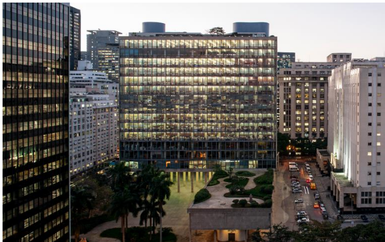
Figura 13: Volumes do Edifício Capanema
