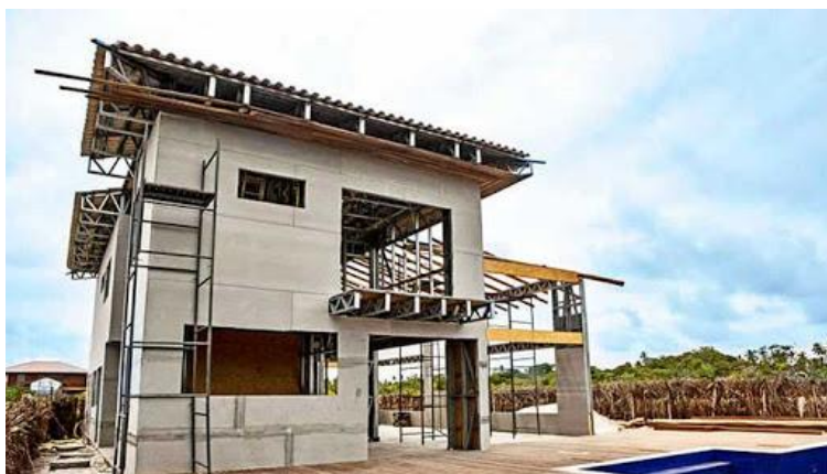
Figura 1: Edificação em estrutura steel frame vedada com drywall
