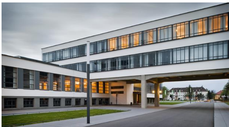
Figura 25: Passarela que conecta alas da Bauhaus
