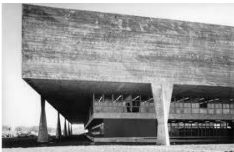
Figura 6: Pilares de sustentação da FAU-USP
