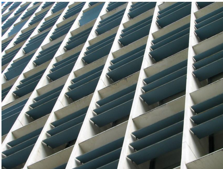
Figura 17: Brises do Edifício Capanema
