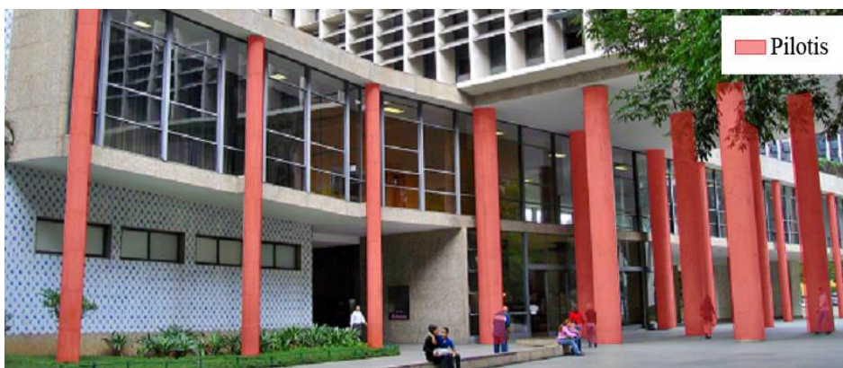
Figura 15: Pilotis do Edifício Capanema
