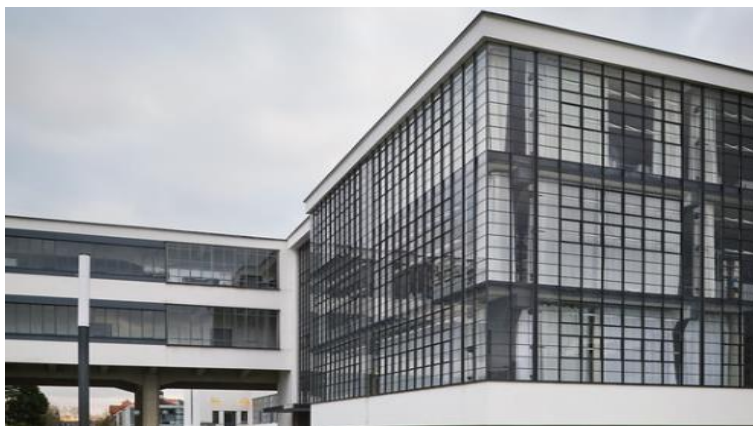
Figura 24: Cortinas metálicas da Bauhaus
