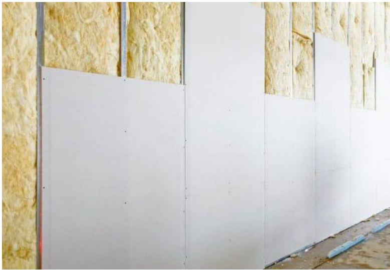
Figura 4: Fechamento em drywall com isolamento acústico.
