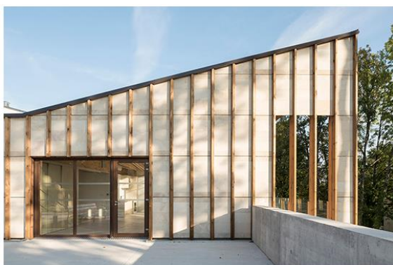
Figura 10 – Estrutura de Madeira
