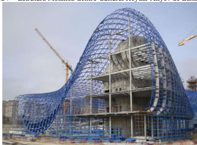
Figura 7 – Estrutura Metálica Centro Cultural Heydar Aliyev de Zaha Hadid
