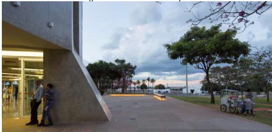
Figura 14 – Vista volume do pilar
