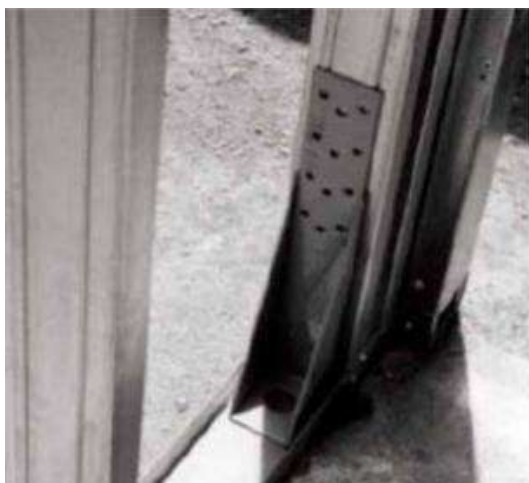
Figura 07 – Ancoragem do painel à fundação.
