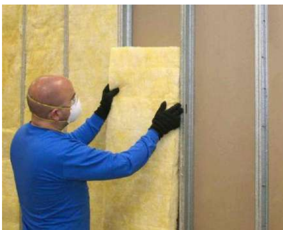
Figura 03 – Instalação Lã de Vidro.
