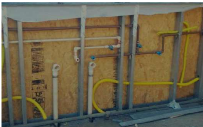
Figura 10 – Instalação Hidráulica e Elétrica.
