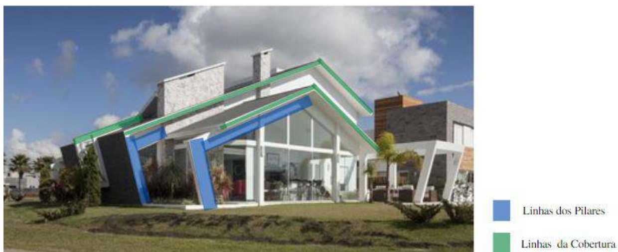
Figura 16 - Análise formal da edificação.
