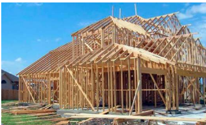
Figura 02 – Sistema Wood Frame
