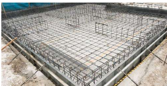
Figura 04 – Fundação tipo Radier
