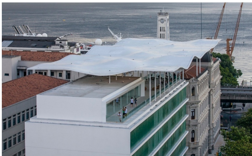
Imagem 12 - Cobertura e praça suspensa.
