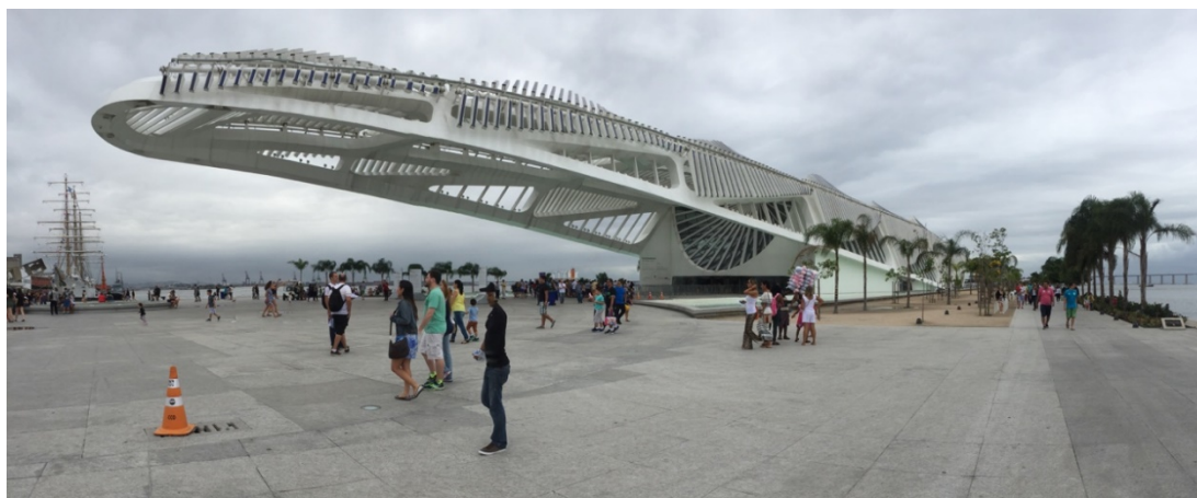
Imagem 13 - Fachada sul (entrada) do museu, mostrando o balanço de 75 metros.
