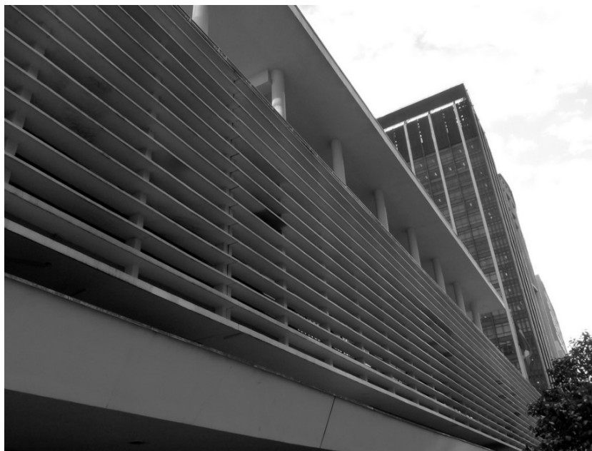
Imagem 08 - Brises que envolvem todas as fachadas da galeria comercial.
