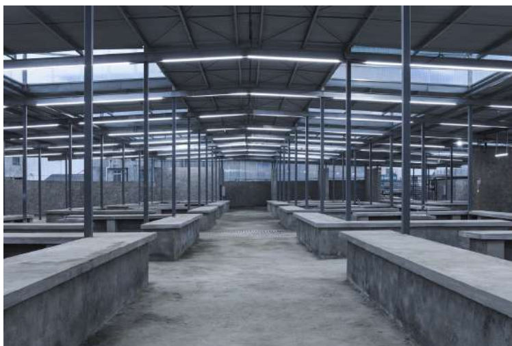
Figura 07: Vista interna do Mercado Público de Longbaxiang, em Shiyang na China.
