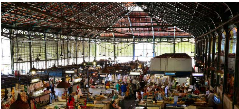
Figura 02: Visão interna do mercado público de São José, em Recife – PE.
