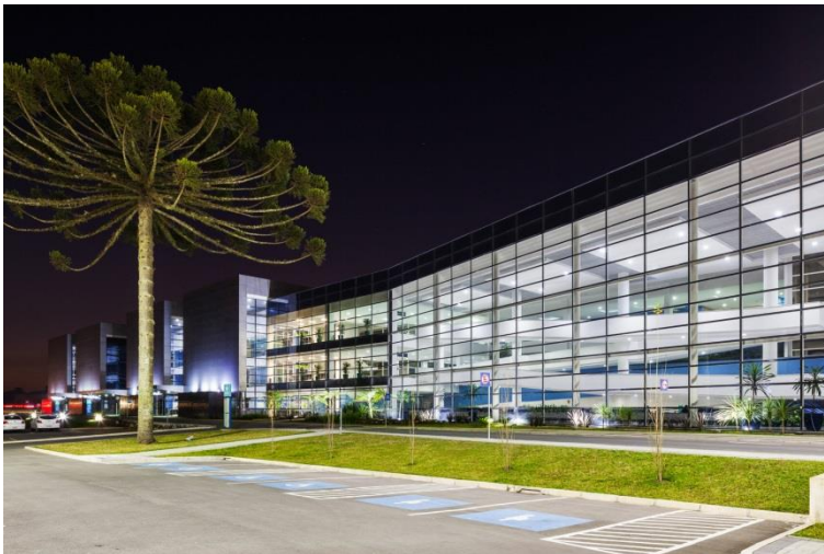
Figura 5 – Fachada Hospital do Rocio
